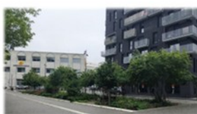
Tranchée de Stockholm © Cerema
