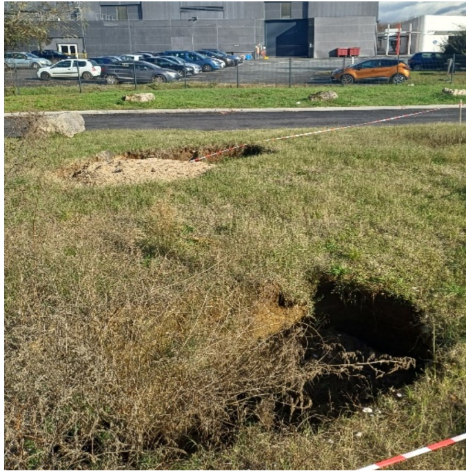
[ illustration 4 Vue effondrement 2 ]
