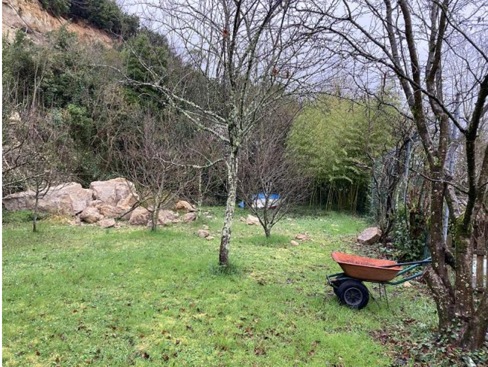
Figure 4 : Éboulement constaté le samedi 2 mars au matin, avec des blocs de volume estimé à 3 - 4 m 3 ©BRGM - C.Garnier)
