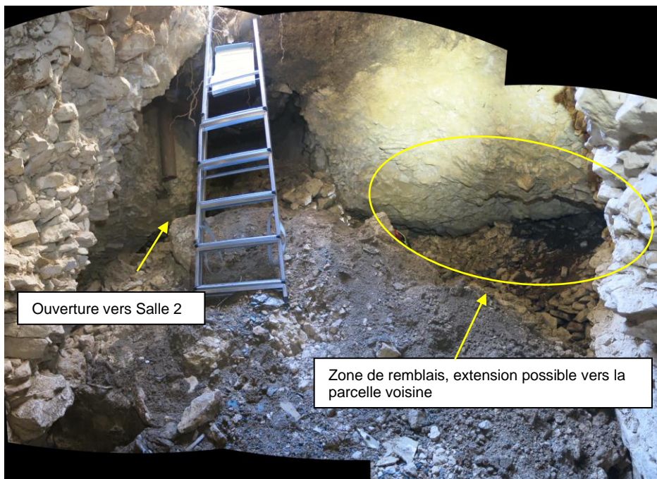
Figure 2 : Vue de la Salle 1 (©BRGM)
