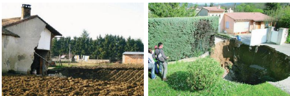
Vues d'effondrements récents : Effondrement d'une carrière souterraine en Gironde (source : site internet de Sud Ouest) et effondrement naturel (gypse) dans le Var (source : BRGM)
