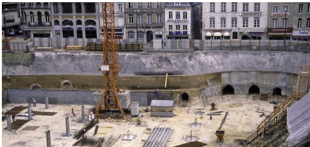
Exemple de cavités découvertes en centre ville au cours de travaux d'aménagement (source : site internet de la ville de St Quentin)
