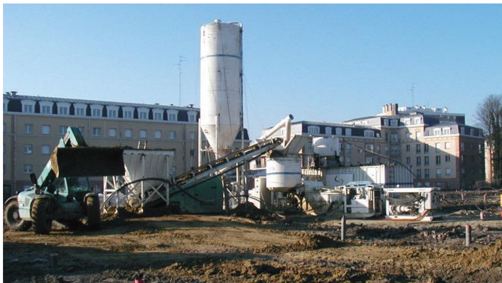
Travaux de comblement à Valenciennes (source INERIS)
